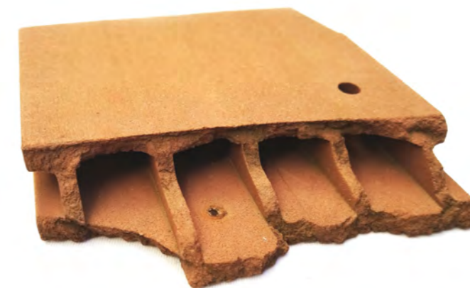
La imagen muestra una tabla deteriorada debido a la falta de cobertura apropiada ante condiciones climáticas y atmosféricas, como las que se dan en exterior. Además, las tablas de Primera Generación pueden sufrir agrietamientos, debido a los procesos de expansión y contracción del material expuesto al sol y el agua.
